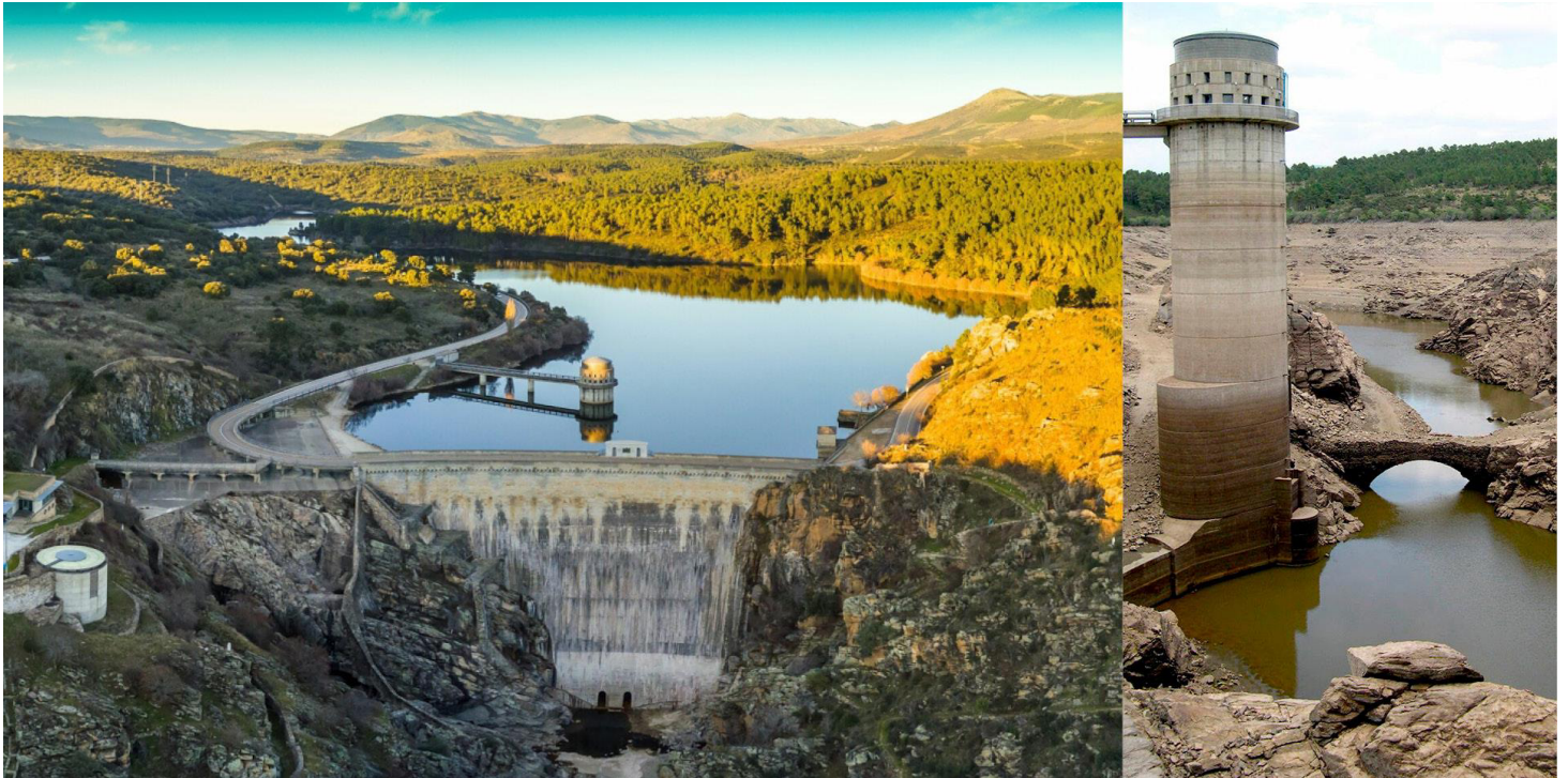
torre de toma de hormigón armado
